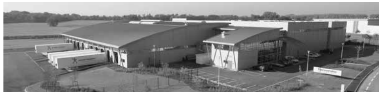
Plateforme logistique Strasbourg
